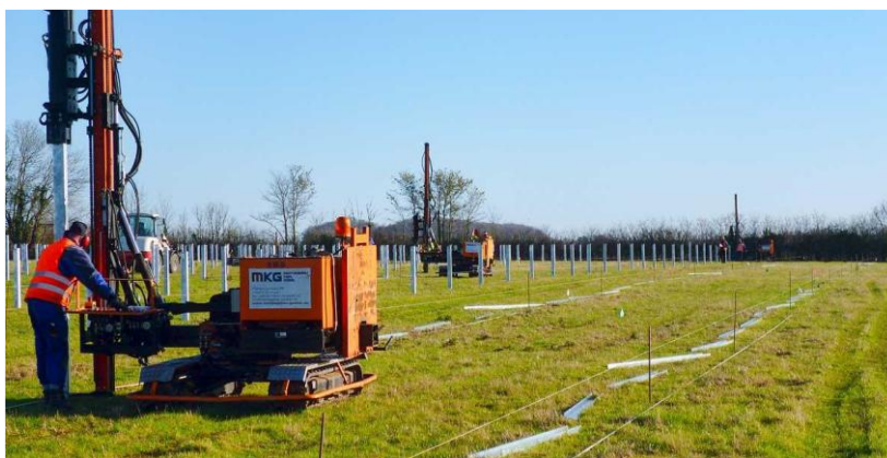
Abbildung 11: Rammgerät zur Installation der Pfosten einer Agri-PV Anlage
