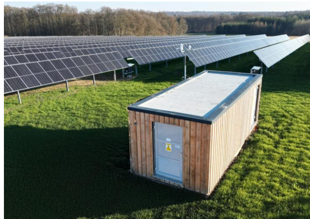
Abbildung 12: Holzverkleidung der Transformatorstation bei der Agri-PV Anlage in Kehlen
